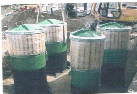
Bijlage 5 : polyethyleen of glasvezel recipiënt met draagzak of draagbak
