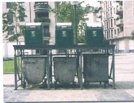
Bijlage 4 : traditionele container op hydraulisch liftend platform met inwerpzuil
