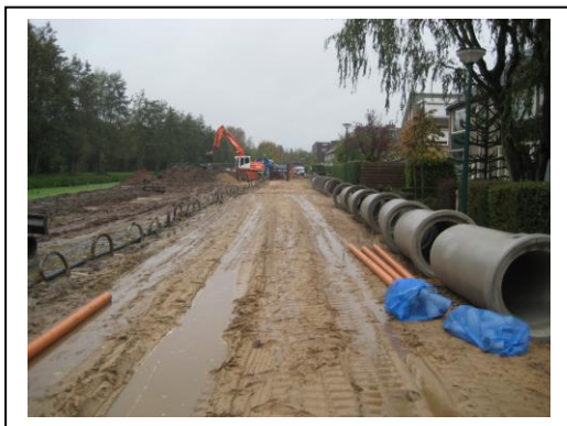
Figuur 3: Voorbeeld riolvergroting
